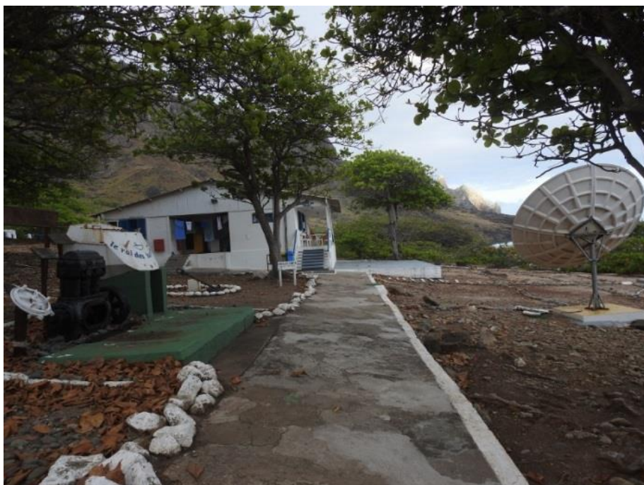
Prédio do comando
